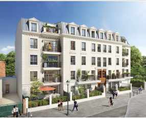
REGAIN 536-538 Avenue du Général de Gaulle CLAMART (92)
